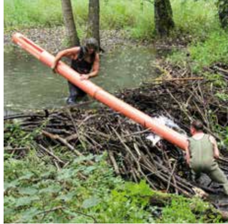
Mitarbeiter beim Einbau eines Drainagerohres
