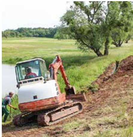
Gittermatten werden am Ufer eingebaut
