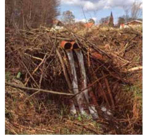
Biberdamm mit eingebauter Drainage
