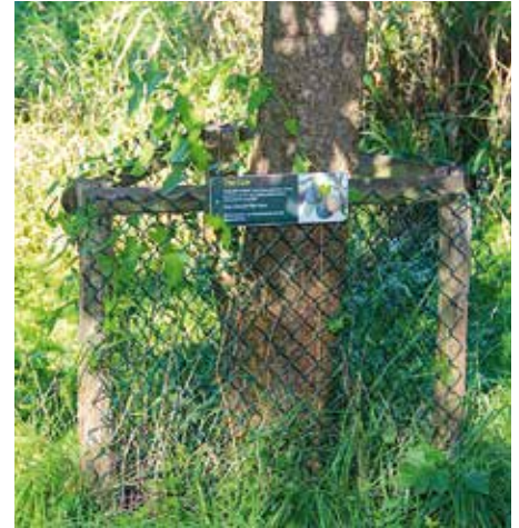
Maschendraht mit Holzpfosten
